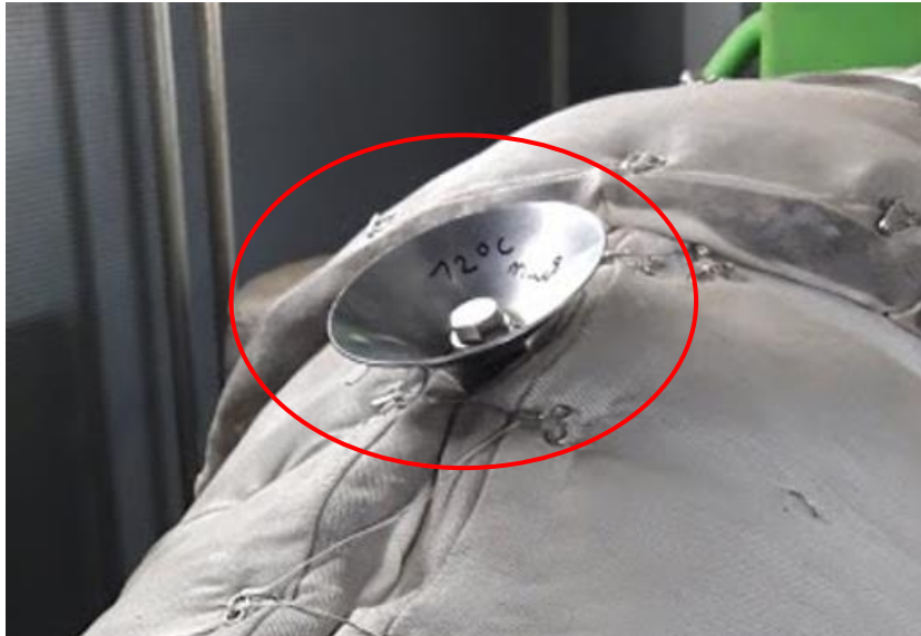
Abbildung 4 – Eingebautes Hitzeschutzschild
